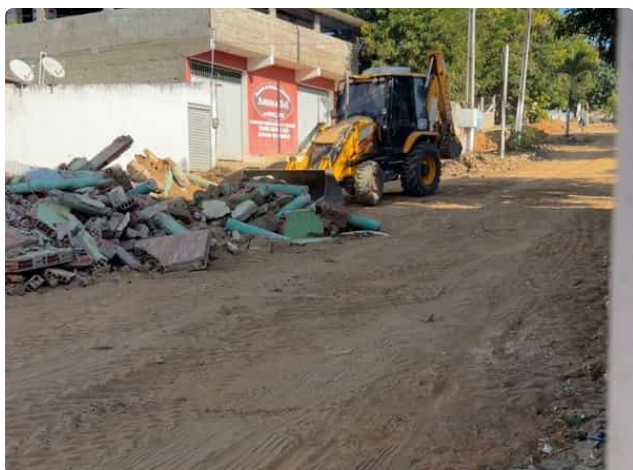
01/09/2026 · Diário Nº 001 demolição
